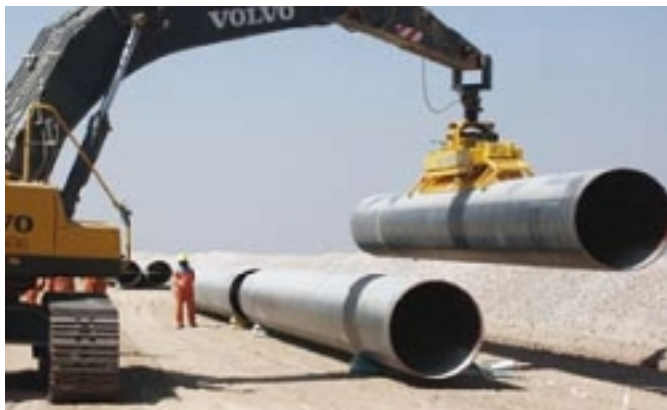
VACUVIETZ работа с экскаватором с гидра
