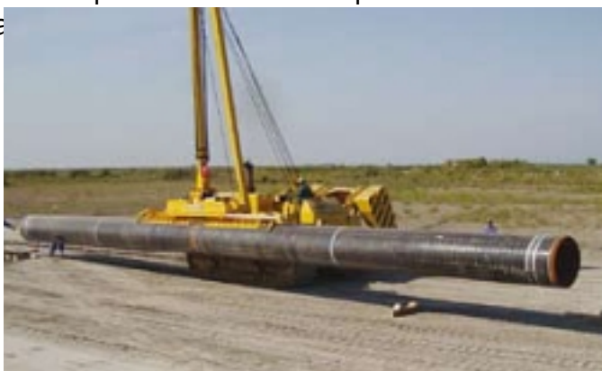
VACUVIETZ с двойными присосами (Twinpads) для трубных секций на боковой стреле
