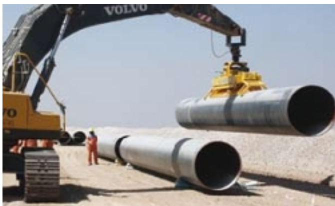
VACUVIETZ работа с экскаватором с гидра
