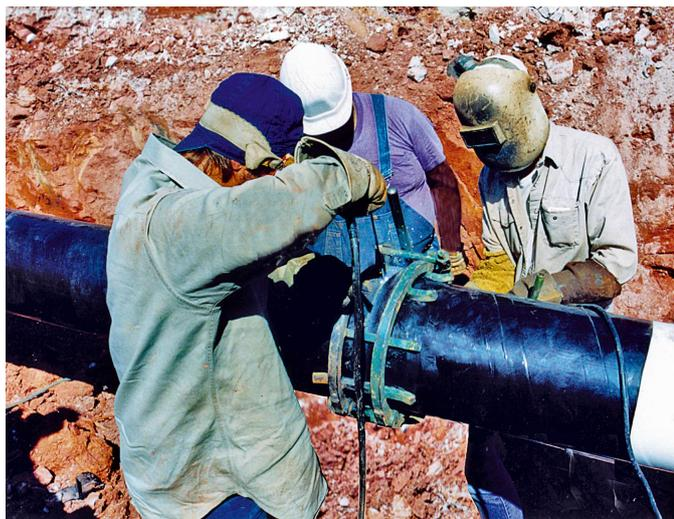
Центратор «Cage Clamp» имеет несколько моделей для труб диаметром 57–1520 мм: с ручным, храповым и гидравлическим механизмами. Модели с фигурными распорками позволяют производить сварку, не снимая центратор с трубы. Центратор «Cage Clamp» предназначен для соединения труб под сварку.
