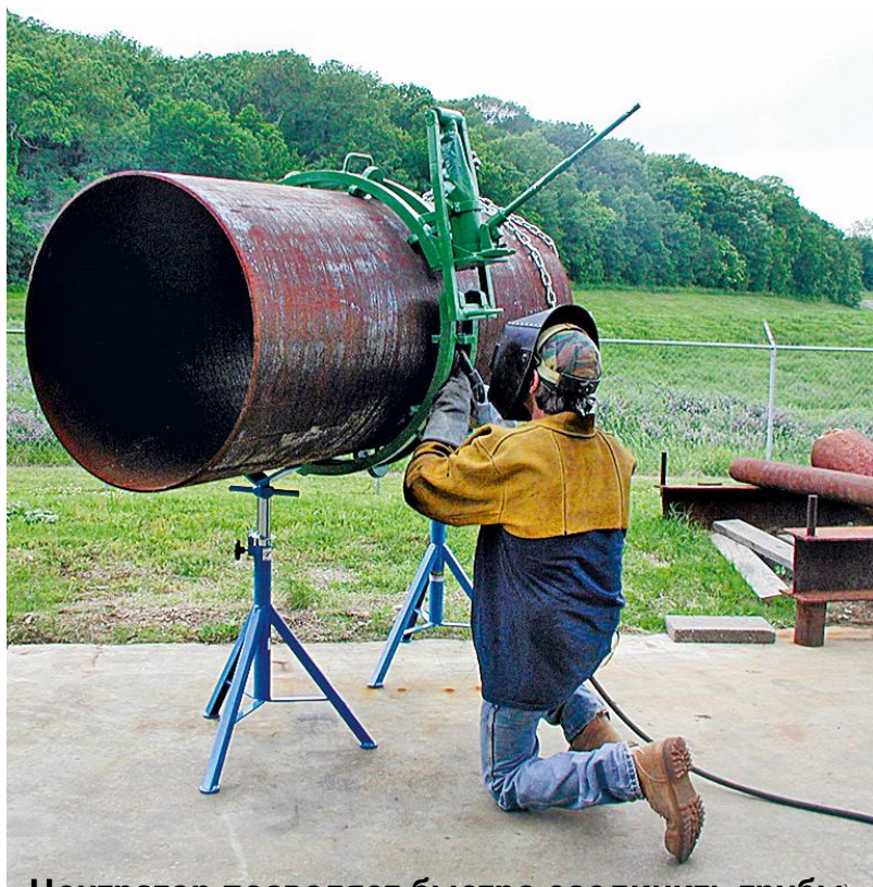
Центратор позволяет быстро соединить трубы
